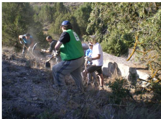
A la izquierda, un grupo de voluntarios trabaja para recuperar un antiguo aljibe en desuso, retirando la tierra compactada y adecuando la ladera para su reutilización como depósito para alimentar una charca para anfibios; a la derecha se observa el aljibe recuperado. Montejo de la Vega (Segovia).
