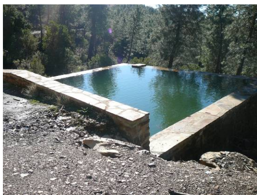
Depósito de hormigón y presa de tierra en Cáceres. Fuente: EPRIF, Área de Defensa contra Incendios Forestales del MAGRAMA
